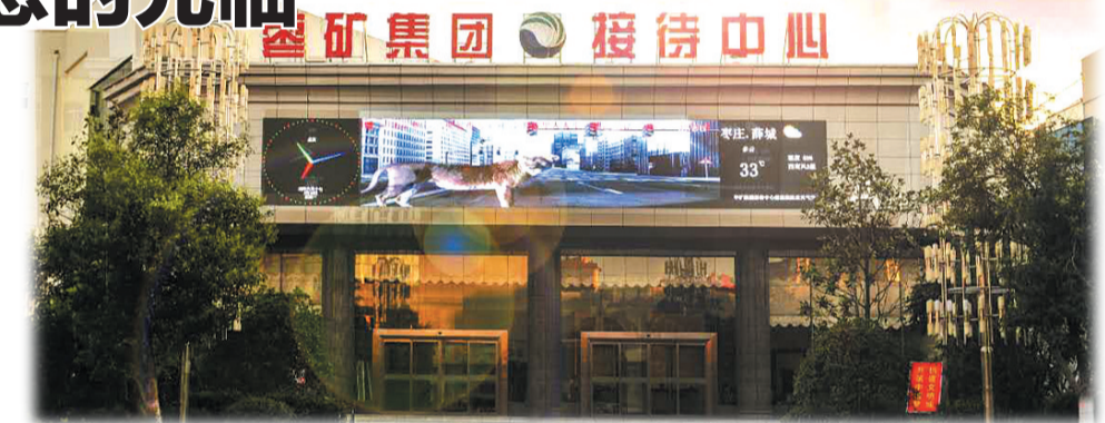
枣矿集团接待中心外景
