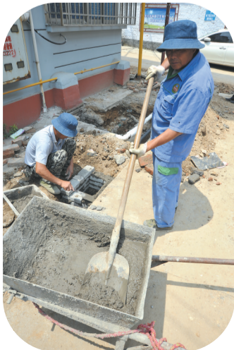
老旧小区改造现场
