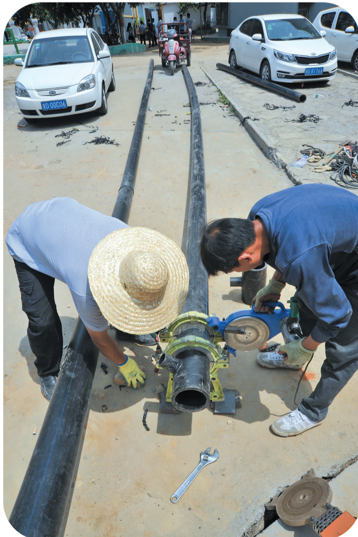
老旧小区改造现场
