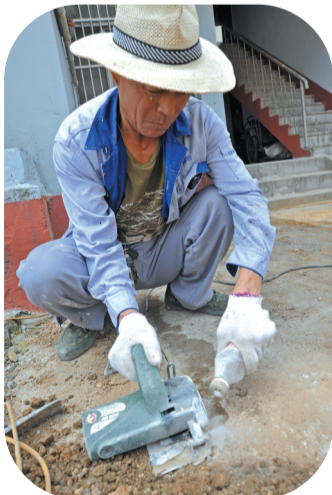
老旧小区改造现场
