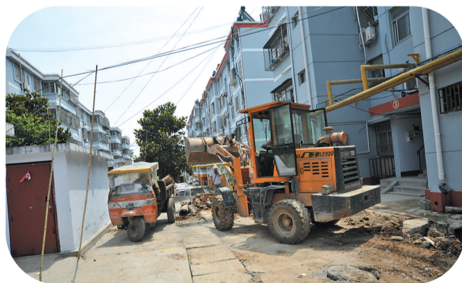
老旧小区改造现场
