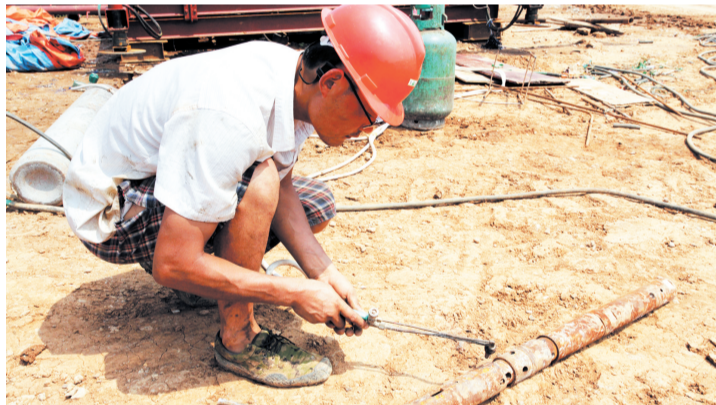
焊接工人一丝不苟地焊接机械部件。
