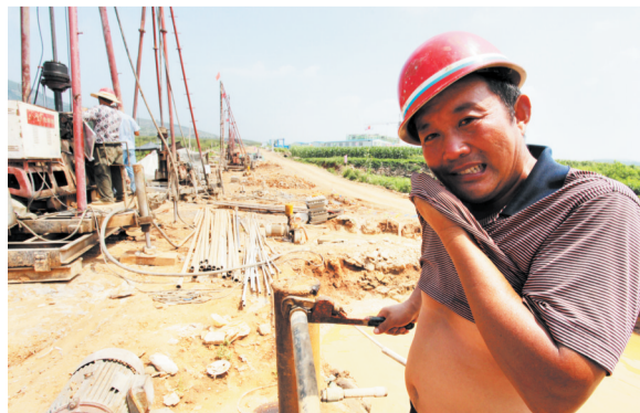
为了不耽误施工,直接把汗衫当毛巾用。
