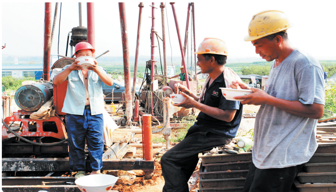
大中午的工程人员在烈日下吃午饭,为赶工程进度。
