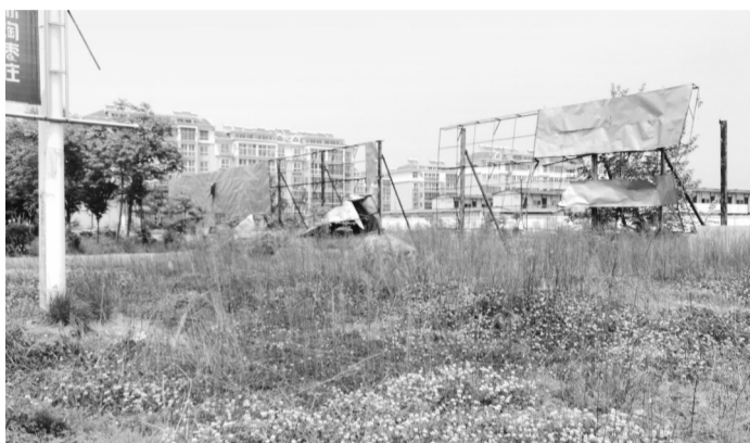
解放南路有一处大型的广告牌严重破损只剩下一副骨架
