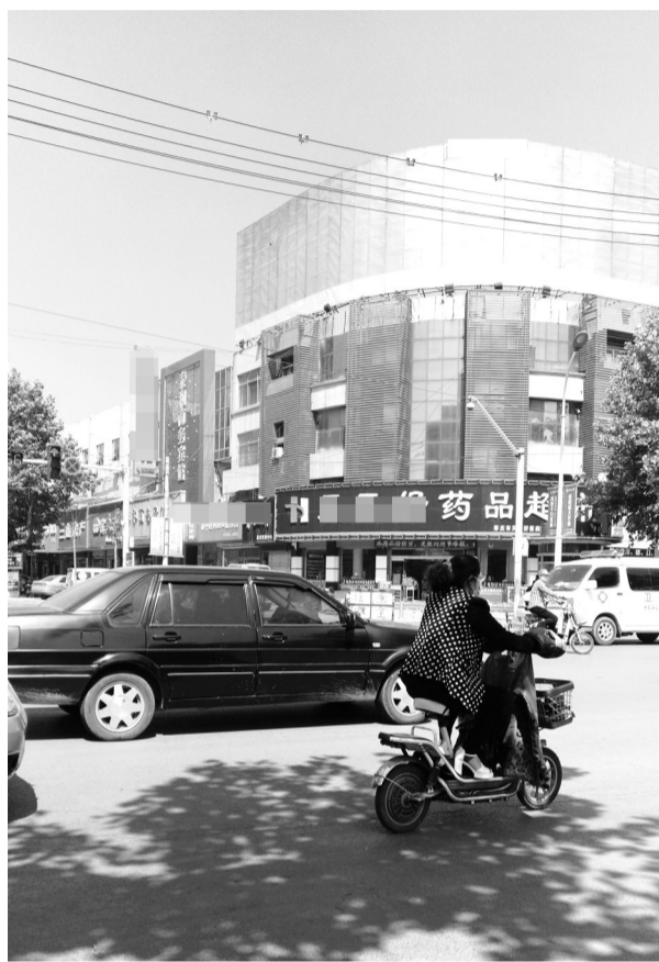
亚细亚路口一楼上广告牌长期闲置
