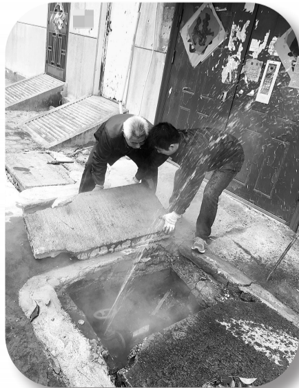
王钰正在管道爆裂现场维修
