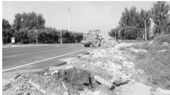
8月17日上午,山亭区城管局执法人员巡查至刚竣工的青屏路与崇文路路口时发现路边有很多建筑垃圾,占地约30平方米,可能会对周边环境造成影响,执法人员找来了铲车,清理了乱堆放的建筑垃圾,及时消除了影响。(通讯员 贾胜伟 于安东 摄)
