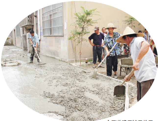
小区道路正铺平施工
