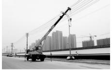
近期,滕州市政处大力实施了通盛路路灯安 装工程。这次路灯安装工程主要涉及大同路至善 国路段,全长1200米,道路两侧共安装10米单臂 高压钠灯58盏,砌筑检查井60座,安装变压器一 台,铺设铝芯电缆2600米。(通讯员 史忠星 摄)
