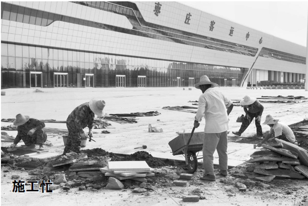
7月8日,枣庄客运中心项目施工人员在铺设地面大理石。该项目在完成土建、主体内墙和外墙装饰等工程后,进入了地面硬化阶段和应用控制系统安装调试阶段。(记者 孙明春 摄)
