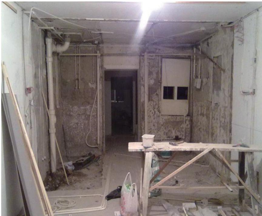
明白了前面的理论,就需要真正的施工了,拆除废旧、损坏、不要的门窗、墙体、地面等。特别要点:拆除门窗,要注意安全,考虑楼下行人。拆除水电要做好绝缘、防漏工作。
