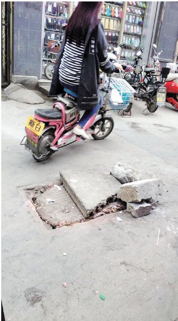
晚报讯 (记者 李俊 摄影报道) 近日,市民张先生拨打本报热线反映,薛城区财富大世界靠近北边的一个窨井盖破损严重,而且这个破损的窨井盖竟然是由稻草、竹子和水泥做成的,里面并没有钢筋。
