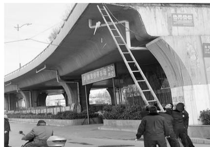
2月2日,滕州市城管局荆河分局组织执法人员对辖区桥体、广告架体、房檐等重点部位进行排查,发现解放路高架桥下“长”了5处冰凌,其中,位于盈盛楼南门桥下的冰凌直径已达20cm,长度已达2米,随时都有掉落的危险。执法人员立即展开行动,经过1个多小时的努力,成功将5处冰凌全部清除。
