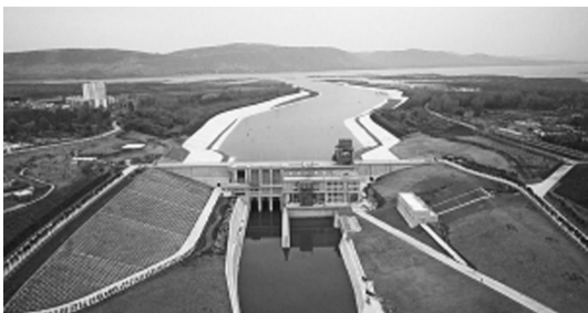
12月12日,长1432公里的南水北调中线正式通水。位于河南省淅川的陶岔渠首枢纽是其总闸门。
