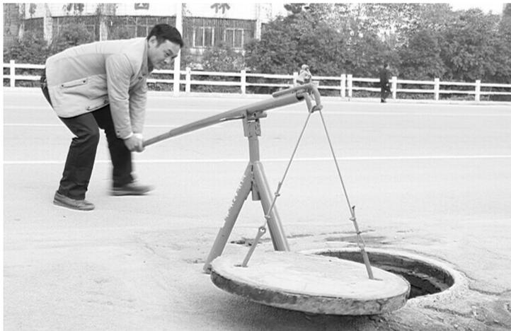
底说了再见。结合城市各个路段的各种井盖,滕州市政路灯所分别发明了液压式开井器、杠杆式开井器、螺旋式开井器、推车式开井器和伸缩式开井器,效果明显,大大提升了工作效率。
