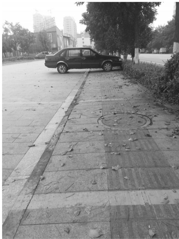
停车位占据盲道
