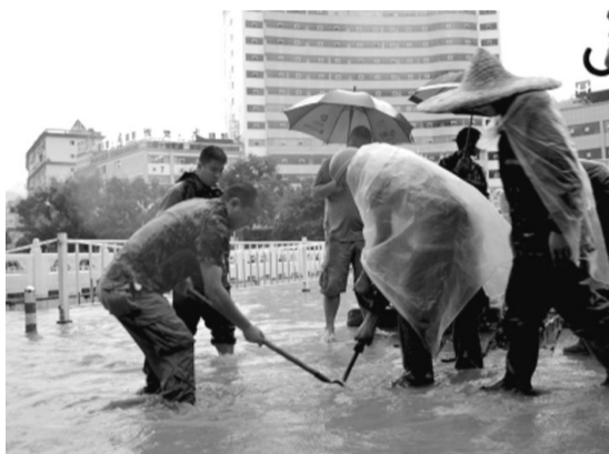
巫溪县市政抢修人员在雨中抢修排水管网
