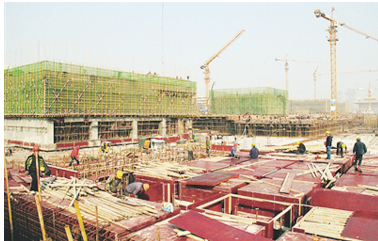
泰安市对辖区多项重点建设项目进行了密切跟踪,对未建项目抓开拓,新建项目抓跟踪,在建项目抓落实,帮助协调解决建设中的各项问题。图为建设中的泰安万达广场项目。(泰安日报)
