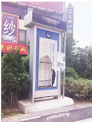
近日,滕州市新兴路步行街南首的一个灯箱坏了,灯箱内连接灯管的电线已裸露出来,存在漏电安全隐患。(特约记者 郭潇繁 摄)
