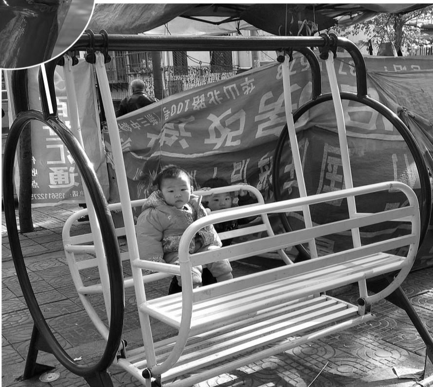
立新小区7号楼南边新装的健身器材部分已经损坏，但仍有市民继续使用已经损坏的健身器材。摇椅秋千一边的焊接处已出现断裂，倘若再继续使用，极易发生危险。
