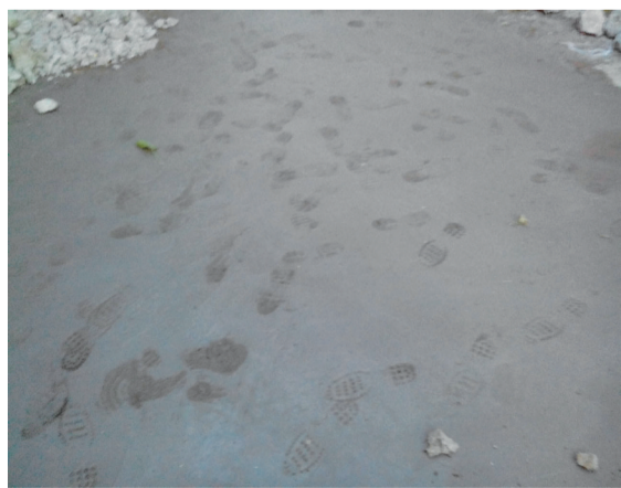
还未干透的水泥路上全是脚印
