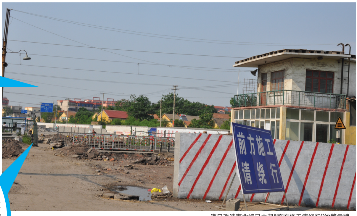
道口改造南北端已立起“前方施工请绕行”的警示牌
