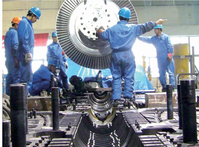
5号机组低压缸双背压双转子互换
