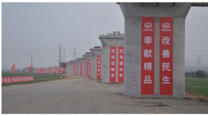
惠民铁路专用线项目建设加速推进
