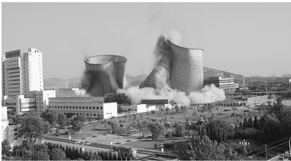
图为爆破拆除瞬间。
