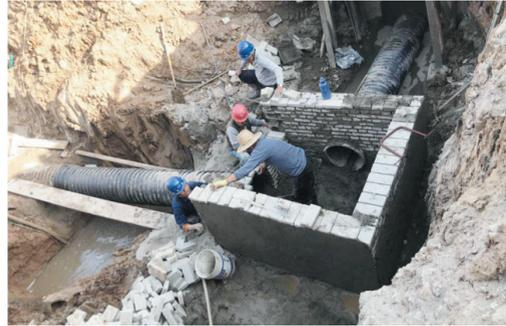
近日，途经新城武夷山路的市民发现，路旁污水管网铺设施工正忙。今年以来，薛城区新城供水有限公司加大了对新城区污水管网综合整治力度，4月5日启动了武夷山路污水管网维修改造工程。该工程投资约35.8万元，将建设污水检查井3座，铺设污水管道140米。工程计划4月底完成改造。完工后，将有效缓解新城武夷山路周边污水排放带来的河道水体及环境污染问题。(通讯员 张金瑞 陈丽君 摄)
