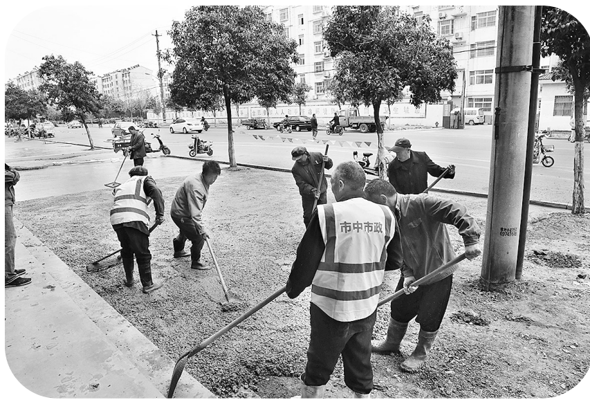
鑫昌路花砖铺设现场
