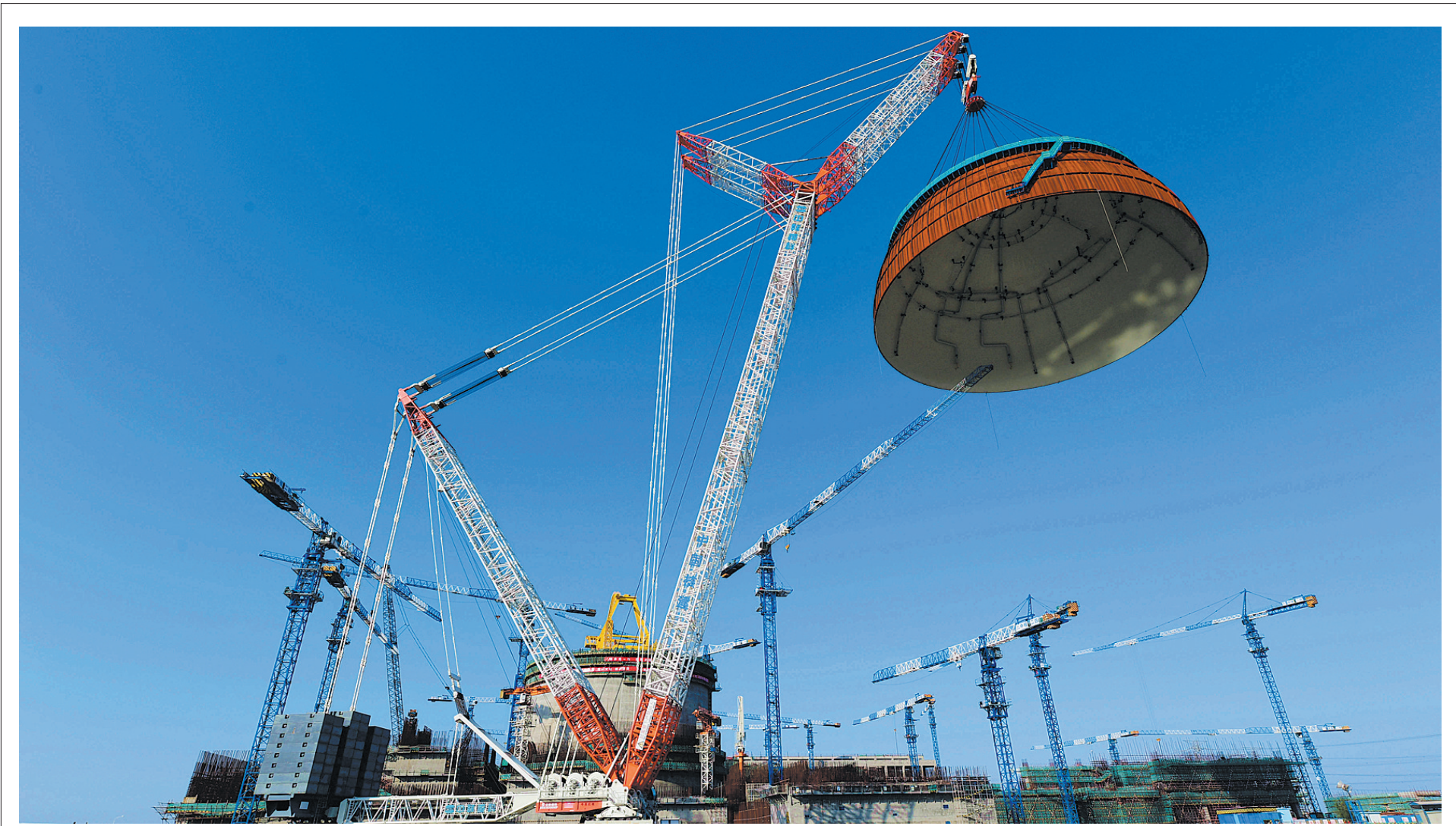
国内第二台“华龙一号”完成穹顶吊装 3月21日，中核集团福清核电6号机组反应堆穹顶正在吊装。当日，中核集团福清核电6号机组完成反应堆穹顶吊装。这是继2017年5月福清核电5号机组之后，国内第二台完成穹顶吊装的“华龙一号”核电机组。穹顶吊装是核电工程建设的重要节点。此次穹顶吊装比原计划提前10天完成，标志着国内第二台“华龙一号”机组建设将由土建工程全面转入设备安装为主的施工阶段，表明我国自主三代核电技术工程建设正在稳步有序推进。（新华社记者 魏培全 摄）
