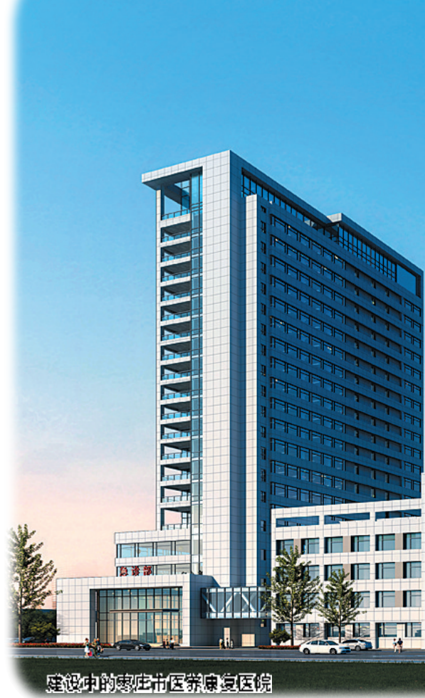
建设中的枣庄市医养康复医院
