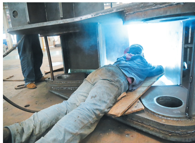
电焊班班长王娜娟在地上进行焊接工作
