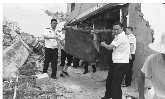
近日,峯城城管局出动50余位队员,对造纸厂片区2处占地约600余平方米的违法建筑依法予以拆除。(通讯员 朱静 摄)
