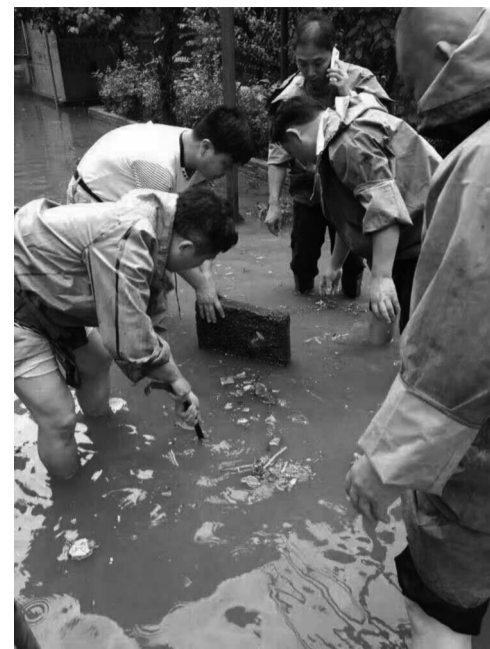
暴雨后街道机关人员清理印染小区下水管道
