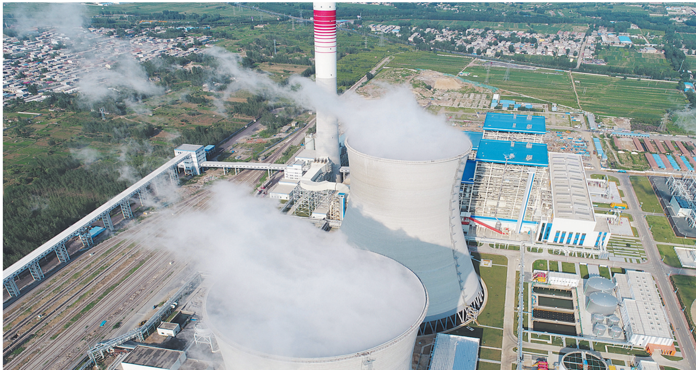
鸟瞰高效超超临界抽凝供热机组
