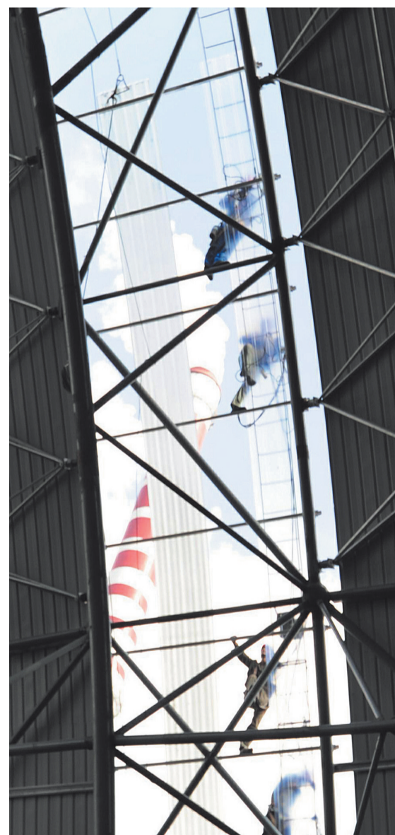
加盖玻璃顶板
