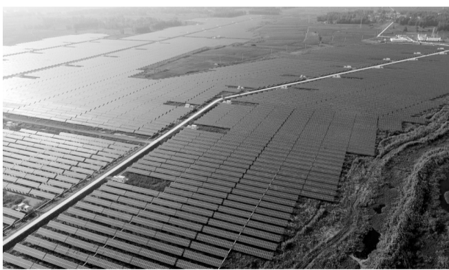
天岗湖光伏发电是华东地区单体规模最大的光伏电站
