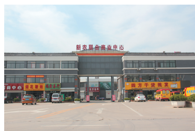
文化路市场改造一期工程——新农联合商业中心
