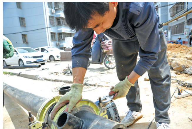
老旧小区改造现场
