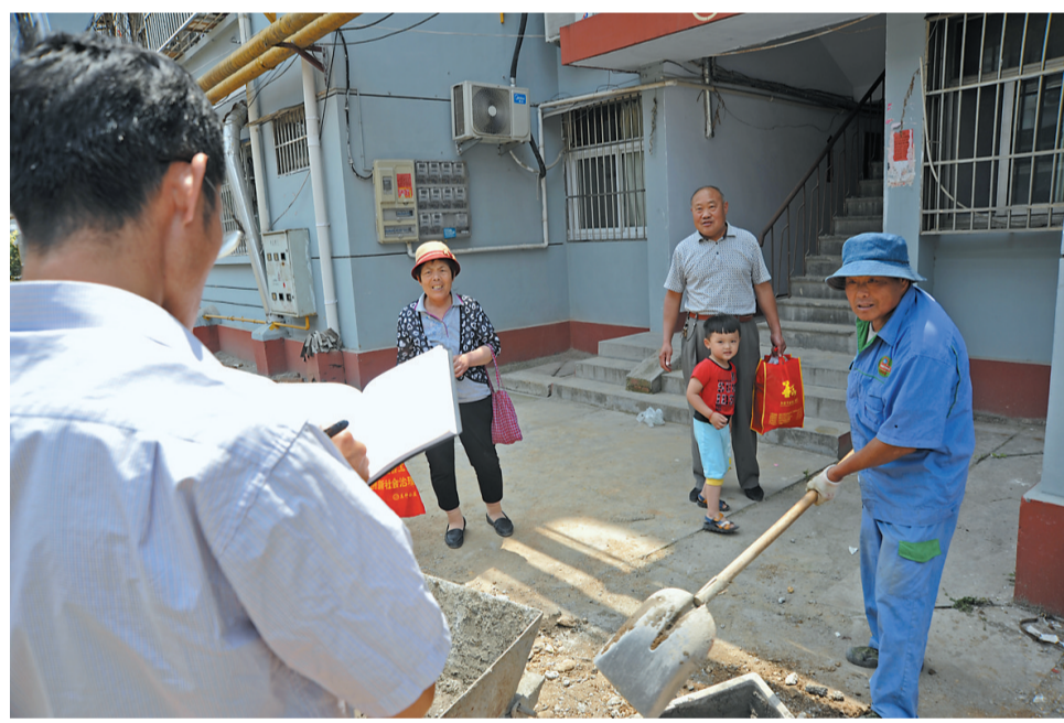
老旧小区改造现场
