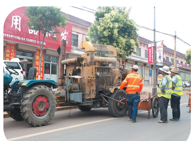
龙头西路道路整修中
