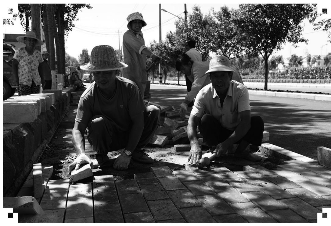
村内道路修建在进行
