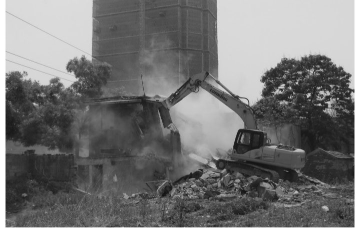
近日，龙山路街道组织人员在焦池里拆除了一座两层房屋。据了解，这座房屋有200余平方米，处于城市整体规划之内。
