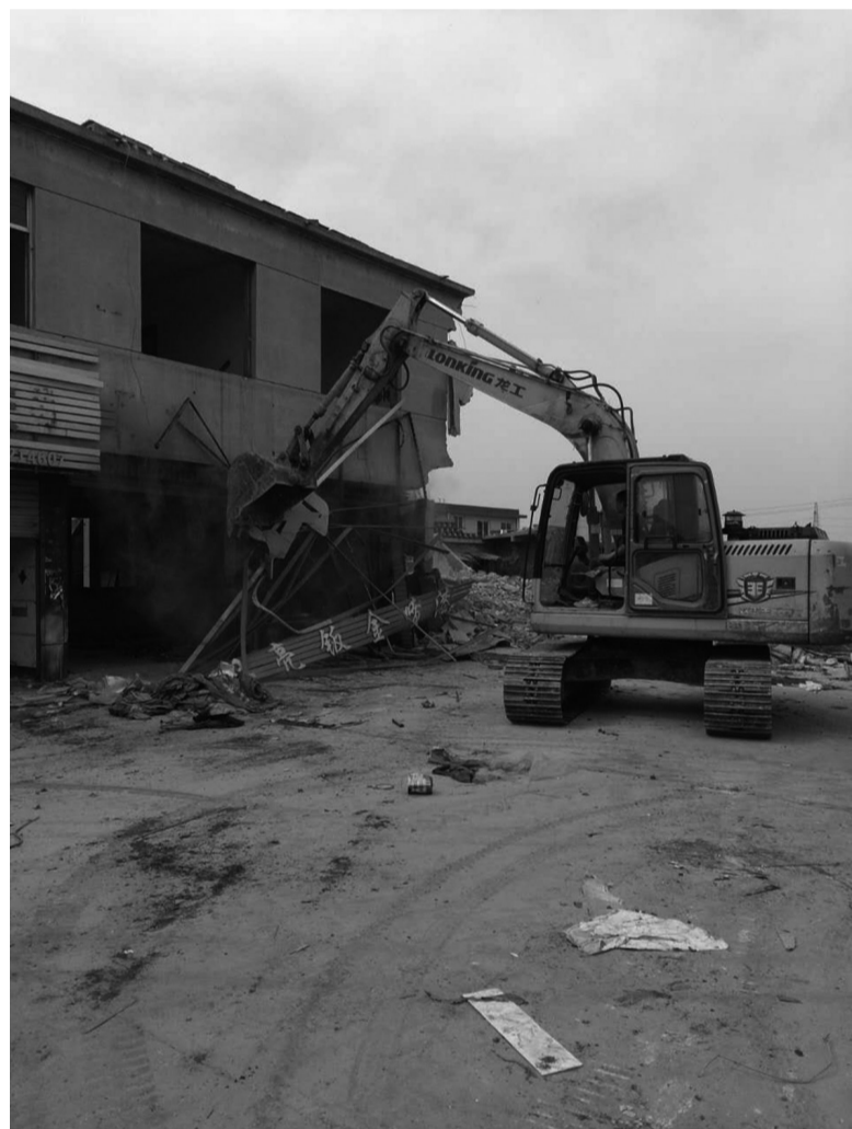
拆除违法建筑
