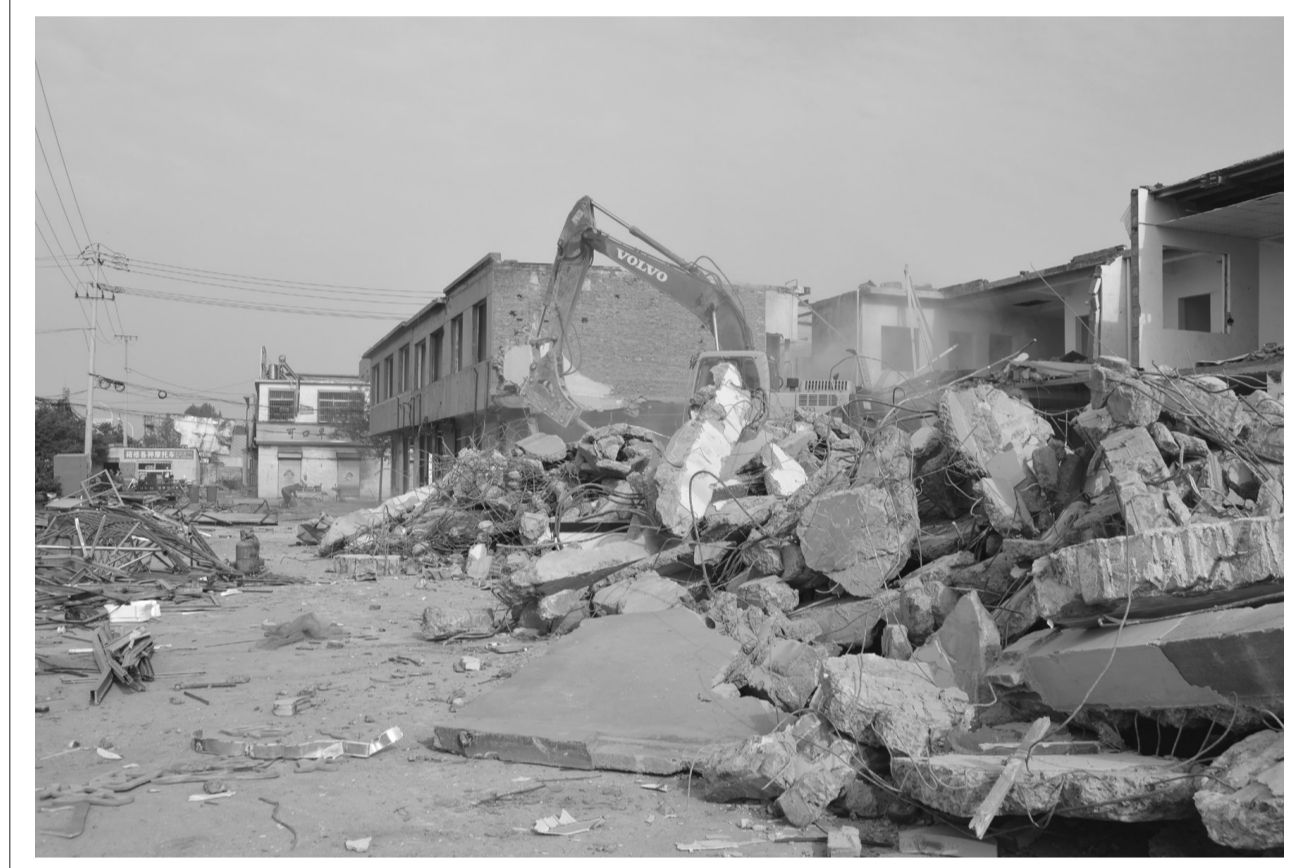
枣木高速公路东延工程进展顺利
