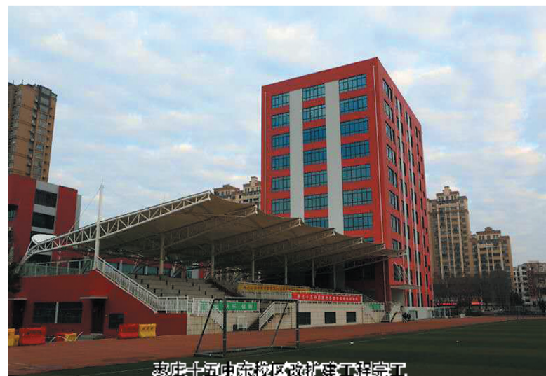
枣庄十五中东校区新教学楼完工
