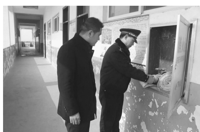
阴平派出所民警深入辖区玩具加工点、驾校、学校等重点九小场所检查消防设施是否配备,是否能正常使用,并对上次检查时消防设施配备不合格的场所进行了重点检查,并对新配备的设施器材进行逐一检验。(通讯员 冯静萍 摄)
