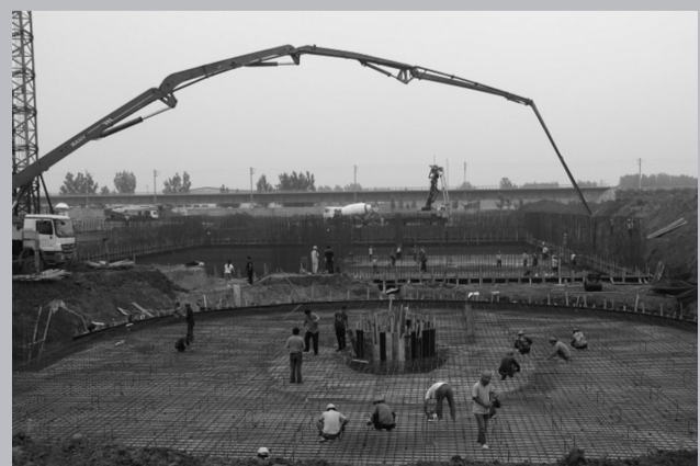
建设污水处理厂
