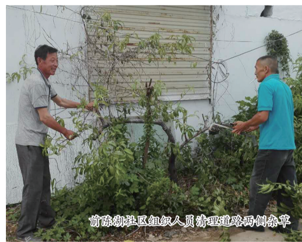
齐村镇整修道路
