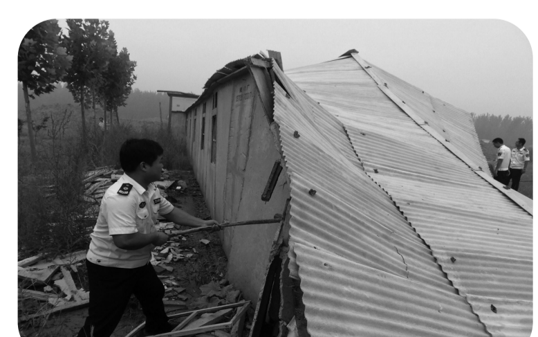
拆除鸭棚现场
