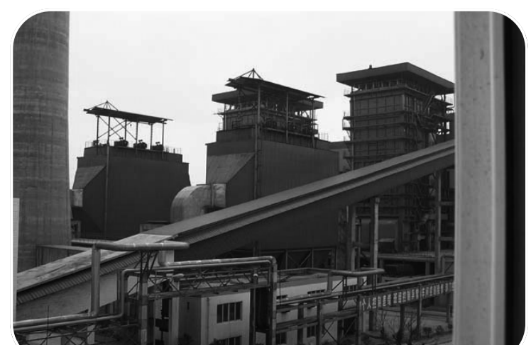
新建环保水泥粉磨站
