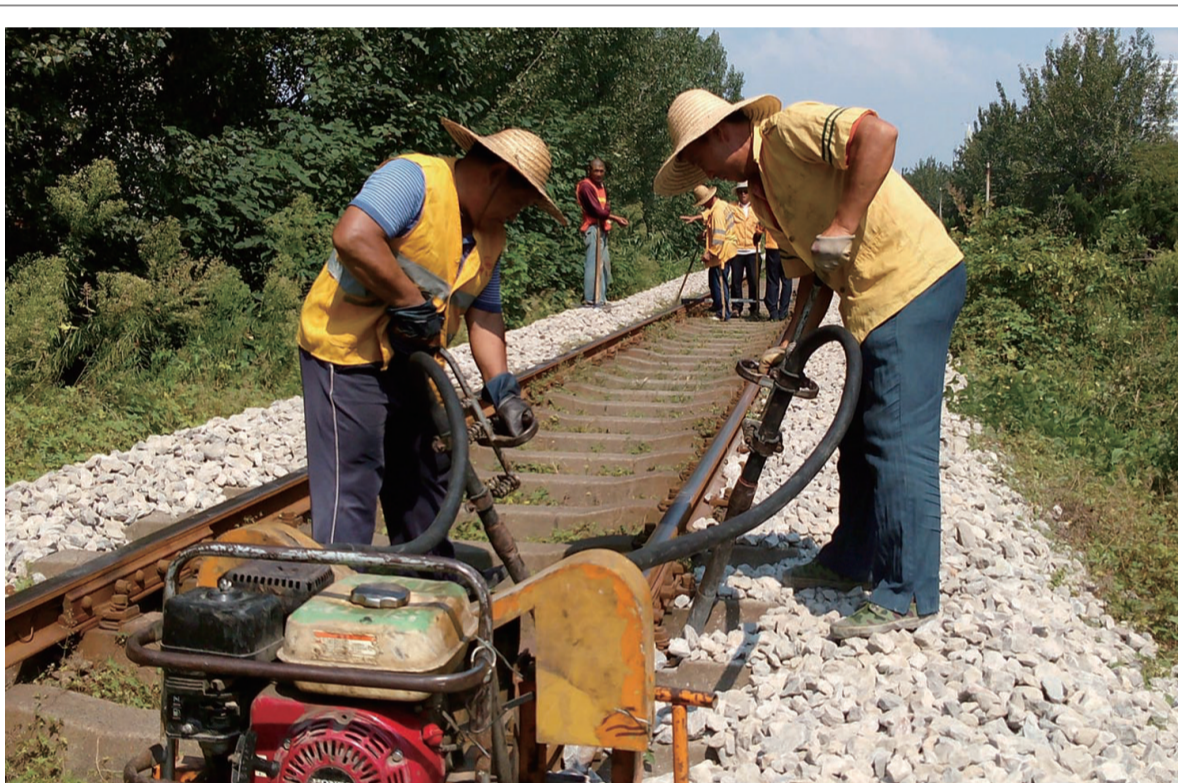
近日,为了确保铁路运输安全,十电支线管理部门按照铁路运输规程,定期巡防铁路安全。图为维护人员正在补充路基石子。(徐瑞福 摄)
