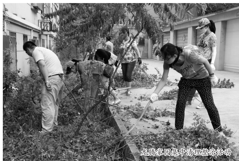
拆除立新小区游园里的违章搭建
