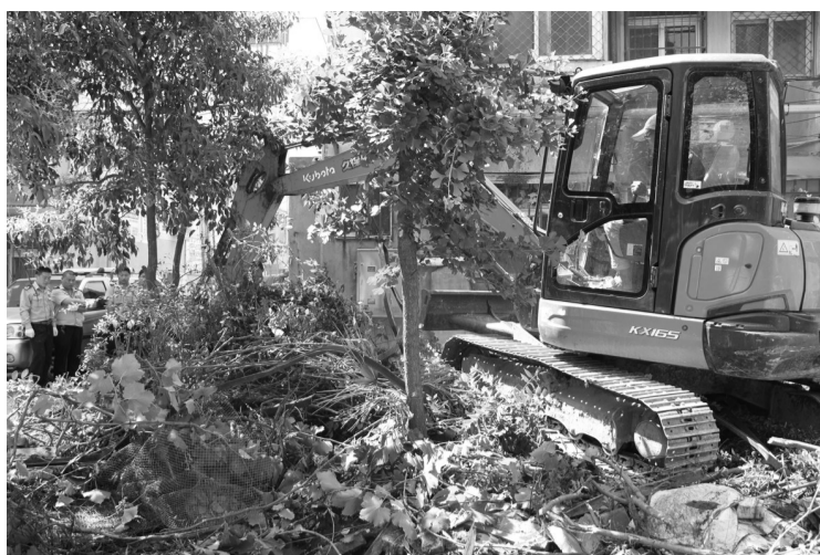
拆除振华小区内侵占绿地的乱搭乱建
