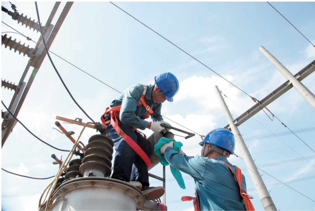
9月8日,枣庄供电公司滕州客户服务分中心员工在35千伏东部变电站内,进行站用变压器小修、预试,打响了该中心秋检第一仗,通过精心检修,消除存在安全隐患,提高设备健康水平,确保东部变电站在迎峰度冬期间安全稳定运行。(徐同超 摄)
