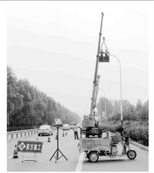
日前,枣庄公路全线路灯维修完工,施工人员对全线665套LED路灯、10套变压器进行排查维修,对不能正常亮灯的322个路灯,缺失灯头24个,缺失灯杆灯头12处,灯杆歪斜10处,进行维护和修理。该路的路灯检修为提升枣庄省际旅游通道,方便旅客进出古城和市民出行提供了便利。(黄传美 新华春 摄)
