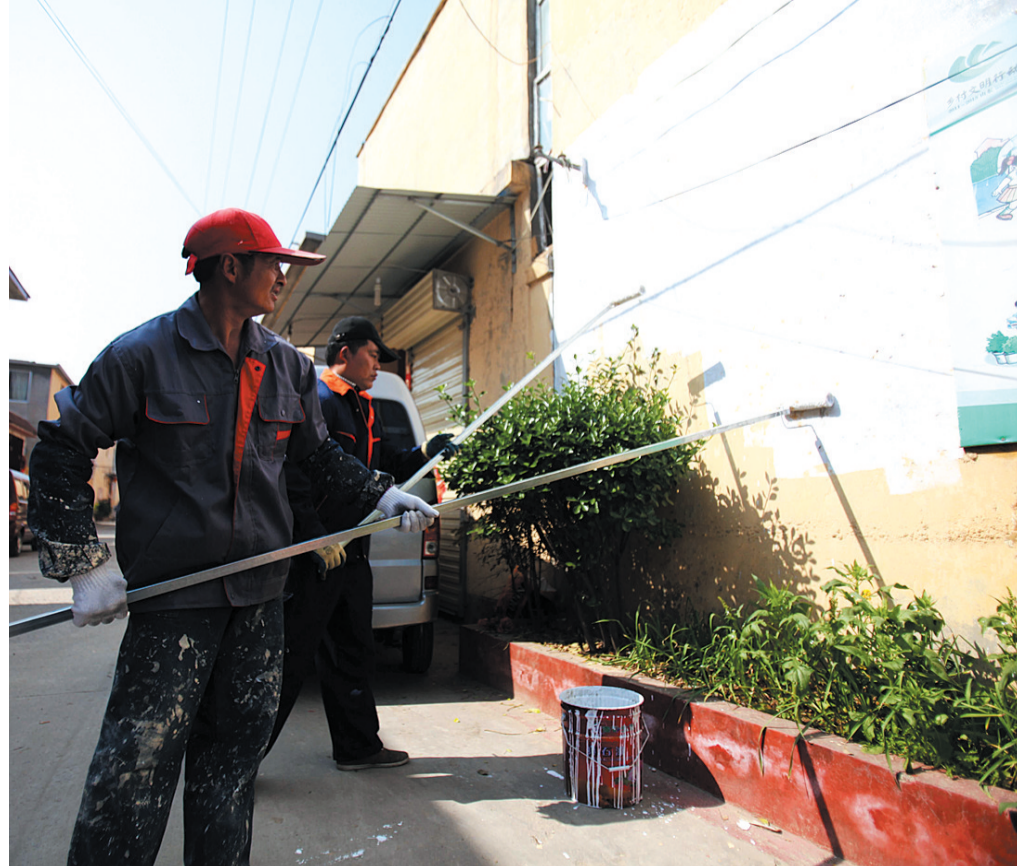
对居内墙壁进行统一粉刷
